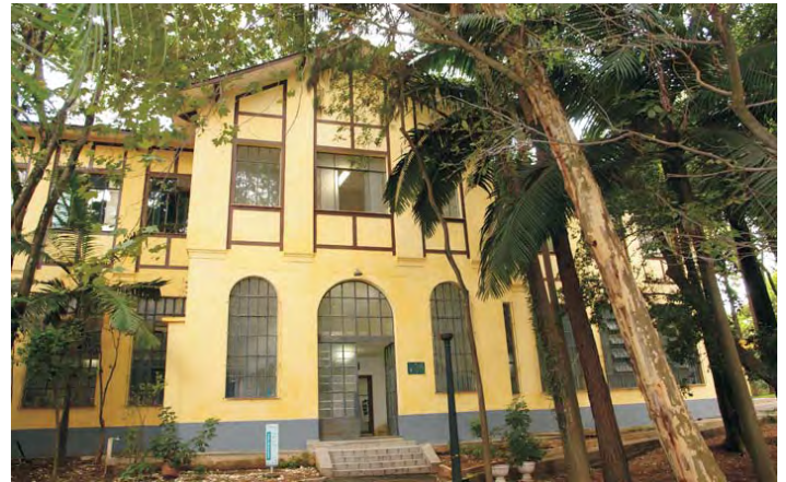
Fig. 1. Fachada do prédio da administração central do Instituto de Pesca. Foto: Roni Oliveira Silva.
